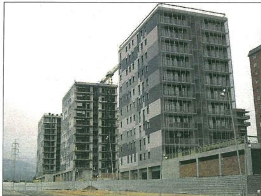
Edificios con 129 viviendas de protección pública en Can Roca II, en Terrassa.
