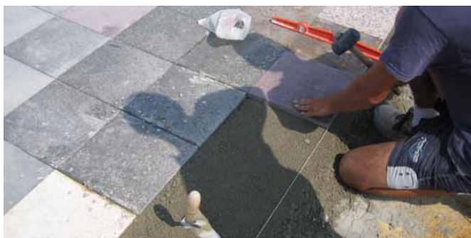
Col·locació paviment de pedra.
