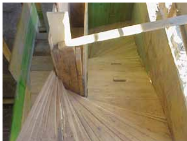
Encofrat escala.
